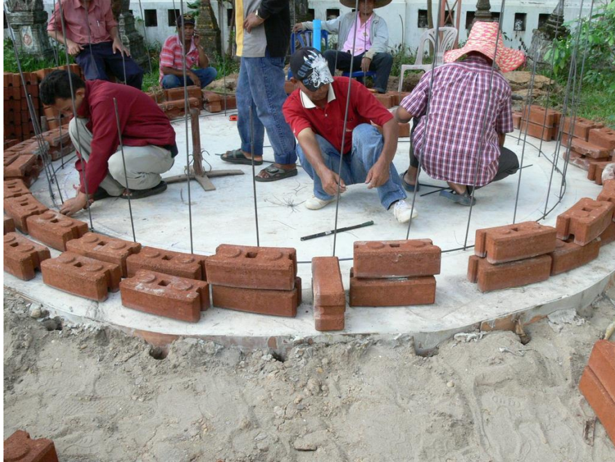
การอบรมการก่อสร้างถังเก็บน้ำบล็อกประสาน วว.
