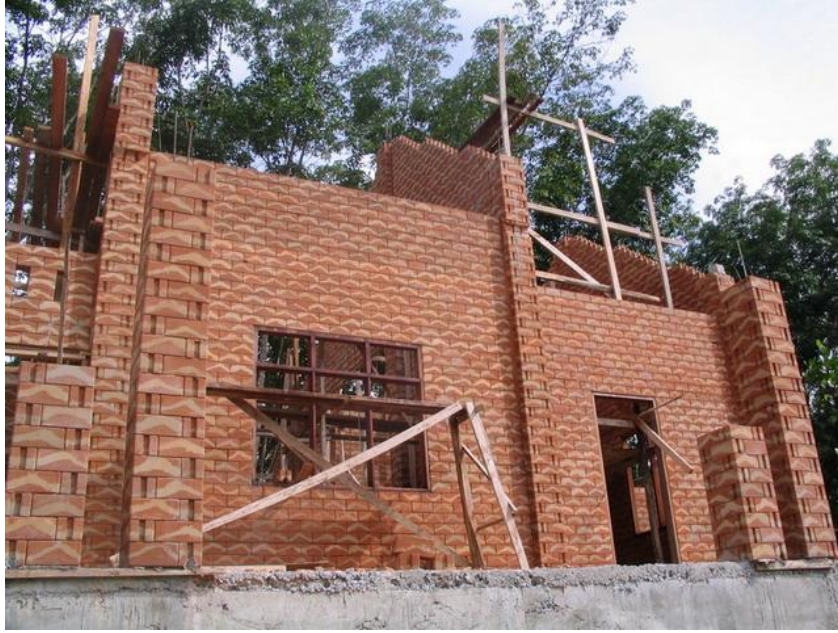
บ้านพักอาศัยบล็อกประสานขนาดใหญ่ จ.นครศรีธรรมราช
