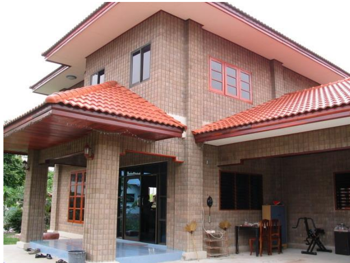
บ้านพักอาศัยบล็อกประสานสองชั้น จ.หนองบัวลำภู
