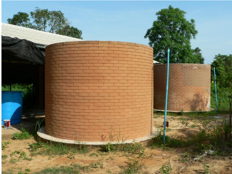
ถังเก็บน้ำลือกประสาน วว.
