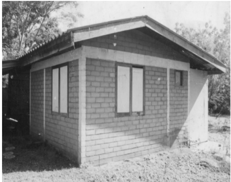
▲ อาคารหลังแรกที่สร้างด้วยบล็อกดินซีเมนต์
