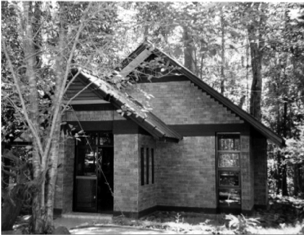
▲ อาคารร้านค้าประชาชนสัมพันธ์ที่สถานีวิจัยสิ่งแวดล้อมสะแกราช อ.วังน้ำเขียว จ.นครราชสีมา
