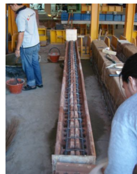
รูปที่ 4 การก่อคานบล็อกประสานชั้นสุดท้าย
