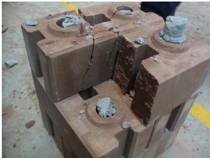
ภาพที่ 7 การไหลเชื่อมประสานกันอย่างไม่ทั่วถึงของปูนเกร้าท์ในก้อนบล็อกประสาน
