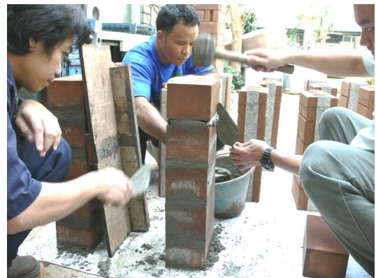
รูปที่ 6 การก่อสร้างรูปชิ้นงานบล็อกประสานตัวอย่าง
