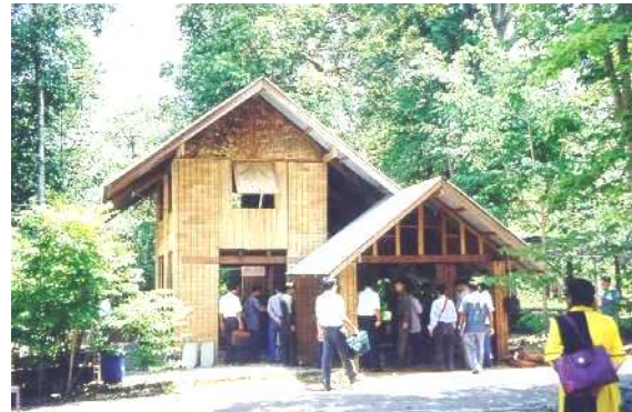
อาคารบล็อกประสานหลังแรกสร้าง เมื่อปี พ.ศ. 2527
